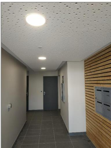
À l'intérieur, de nouvelles boîtes aux lettres ont été intégrées et ne sont plus encastrées dans le mur (ancien accès à la fois intérieur et extérieur), permettant de réduire les pertes de chaleur. Le revêtement du sol (du vieux carrelage) a été remplacé par un carrelage plus contemporain.
