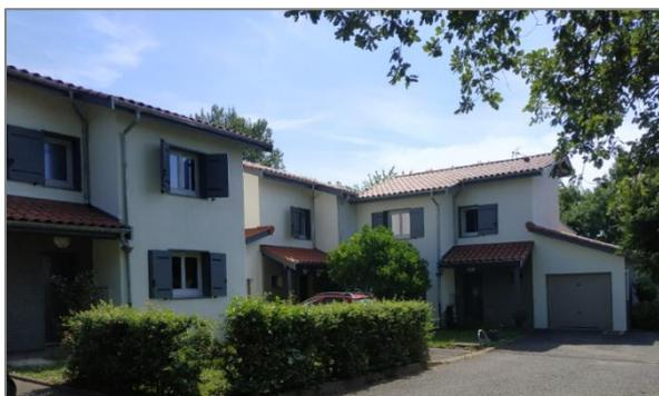
**Comme pour les logements collectifs, les façades ont été ravalées et les menuiseries remplacées par des équipements plus performants thermiquement (fenêtres en PVC, volets battants en aluminium).**
