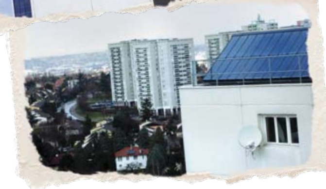
Panneaux solaires et photovoltaïques à la Darnaise - Vénissieux
