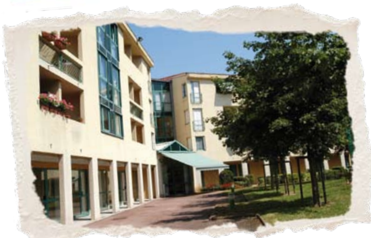
Résidence Vermeil à Rillieux
